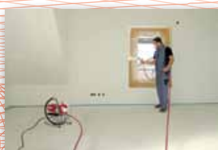
Applicazione di smalto murale su parete rasata, con ugello Fine Finish.
