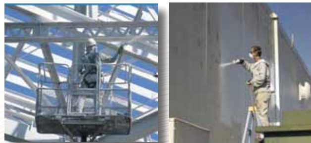
Applicazione di pitture intumescenti o stucchi pronti in pasta
